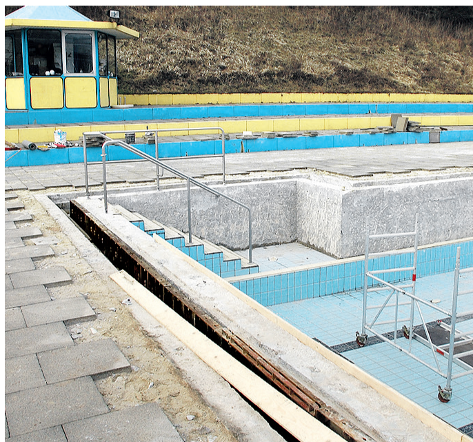
Die Beckenköpfe am Schwimmerbecken werden erneuert.
